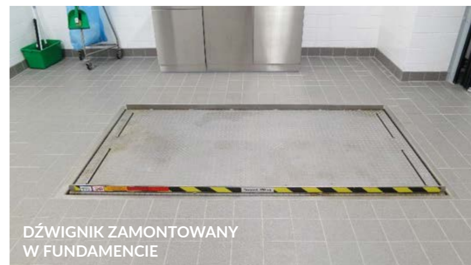
DŹWIGNIK ZAMONTOWANY NA POSADZCE
